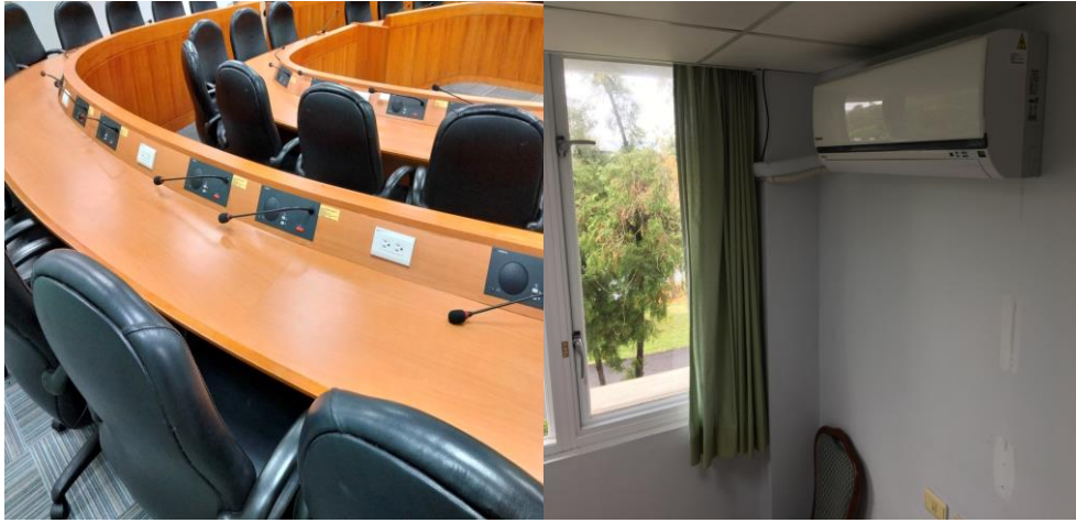
圖13：臺北院區增設教室插座及南投院區汰換宿舍冷氣 資料來源：本學院
